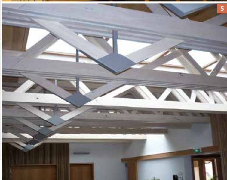
4. Bardage en bois de peuplier thermo-traité 5. Charpente en bois de peuplier à Lezennes 6. Tribunes et vestiaires à Etaples sur Mer
