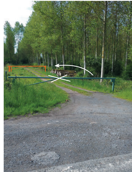
Situation actuelle dangereuse. Après travaux, la barrière a été reculée de 25 m de la route.
