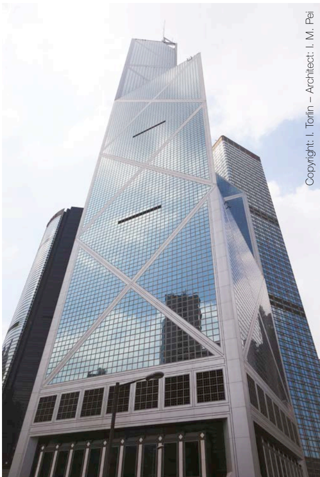
7 | Windverband met behulp van zichtbare andreaskruisen.
