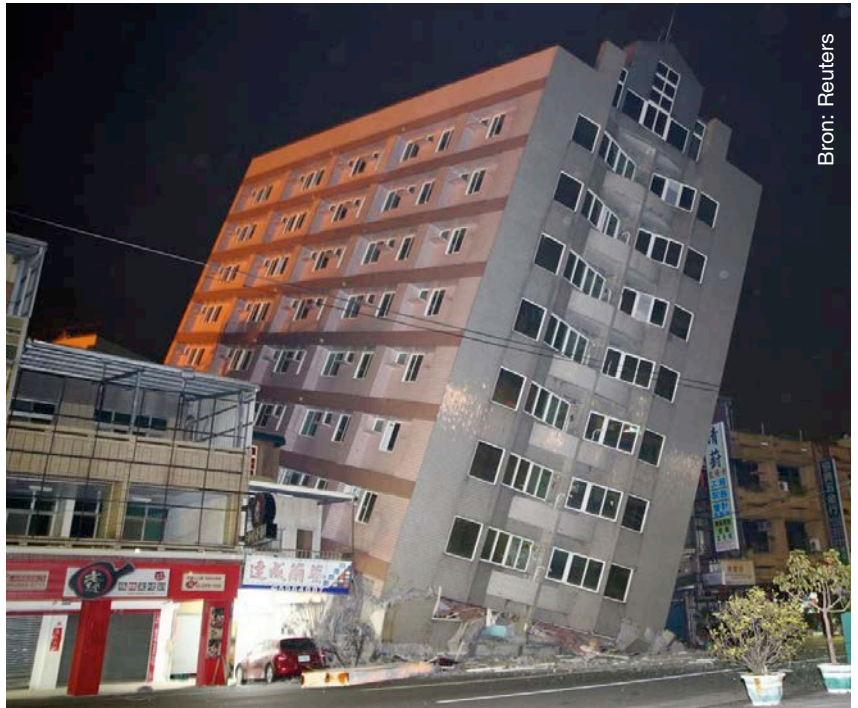
2 | Appartementengebouw waarvan de funderingsplaat gekanteld is ten gevolge van de liquefactie en de daaropvolgende verzakking van de grond tijdens een aardbeving in Taiwan in februari 2016.
