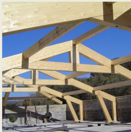
Voorbeeld van balkenconstructie
