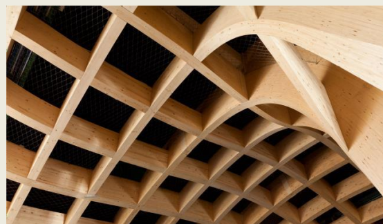
Voorbeeld van structuur waarbij van balken in gelijmd-gelamelleerd hout gebruik gemaakt wordt (Wereldtentoonstelling Milaan 2015, Frans paviljoen, Architect: X-Tu, Foto: Andrea Bosio)
